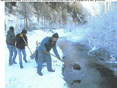
Mise en place de graviers
